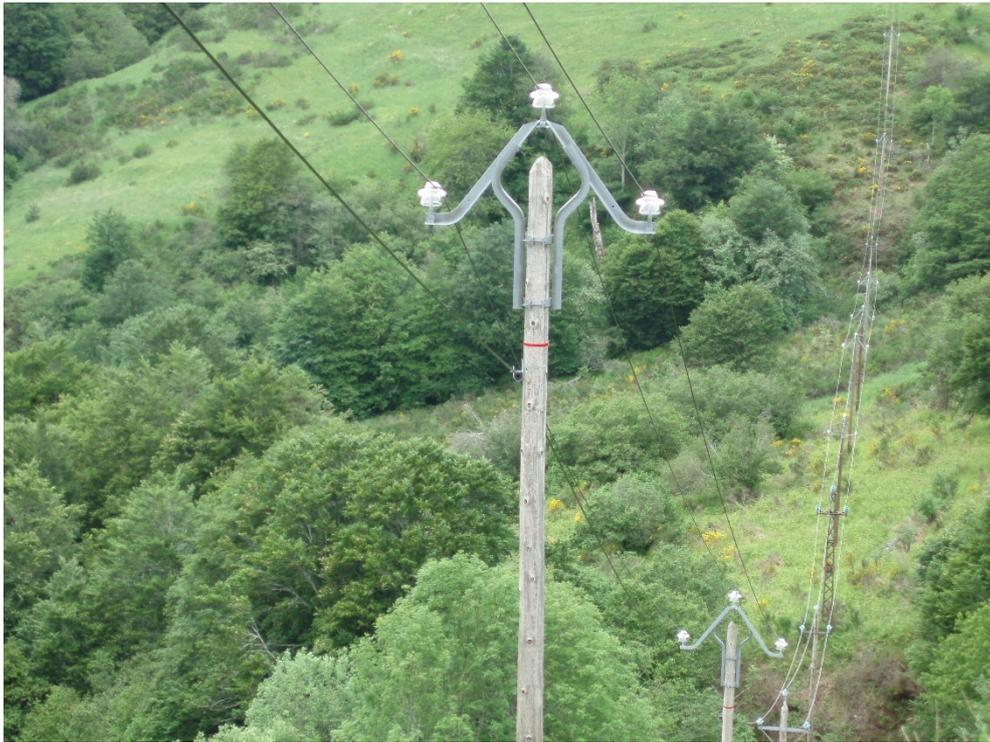
**Exemple de fibre optique posée sous une ligne HTA**
